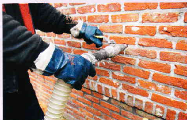
Na-isoleren van spouwmuren.
